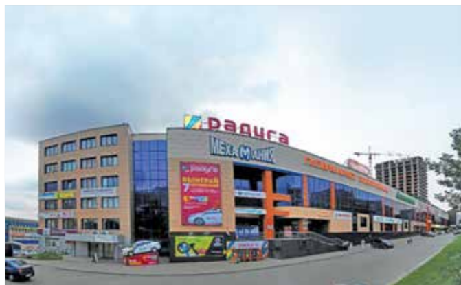
Центр товаров для ремонта «Радуга», г. Уфа. Фанкойлы Electrolux.
