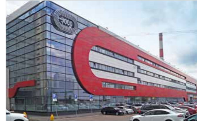
Бизнес-центр «Территория 300», г. Уфа. Мультизональные системы Electrolux.
