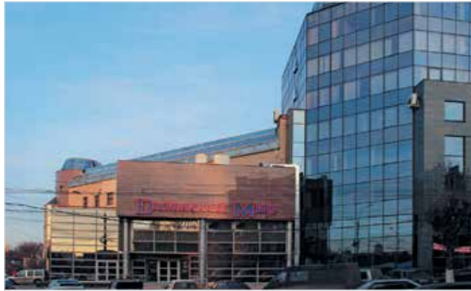
Бизнес-центр, г. Рязань. Мультизональные системы Electrolux.
