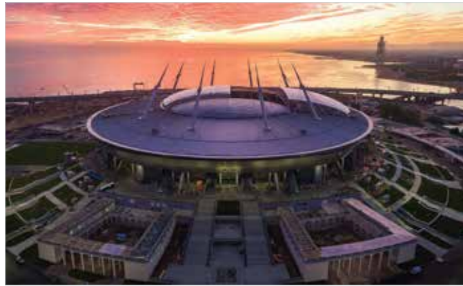
Стадион «Зенит Арена», г. Санкт-Петербург. Мультизональные системы Electrolux.
