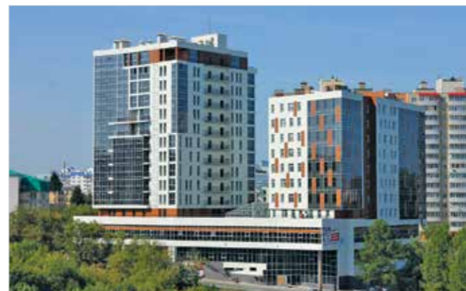
МФК «Альфа Центр», г. Чебоксары. Мультизональные системы Electrolux.
