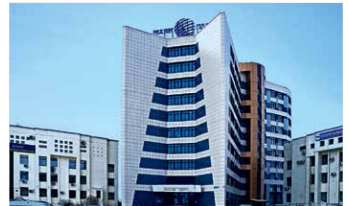
Бизнес-центр «Маяк Плаза», г. Кемерово. Мультизональные системы Electrolux.
