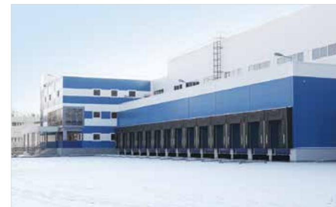
Производственно-складской комплекс Parmalat, М. О., дер. Северово. Мультизональные системы Electrolux.
