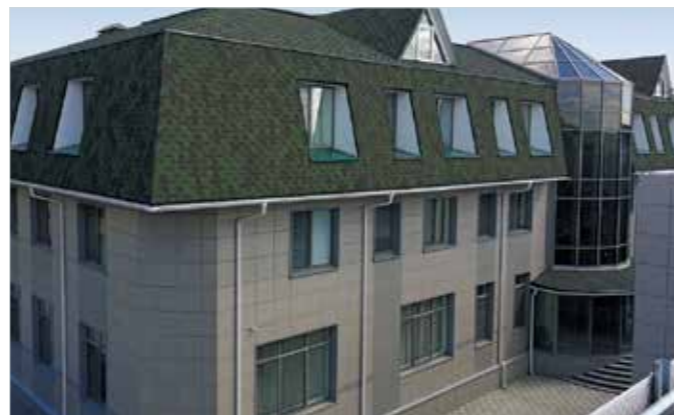
Институт инженерной физики, г. Серпухов. Мультизональные системы Electrolux.
