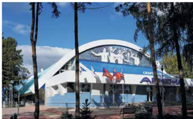
Спорткомплекс «Ледовая Арена», г. Кемерово. Мультизональные системы Electrolux.
