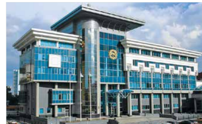
Административное здание «Транснефть-Урал», г. Уфа. Мультизональные системы Electrolux.
