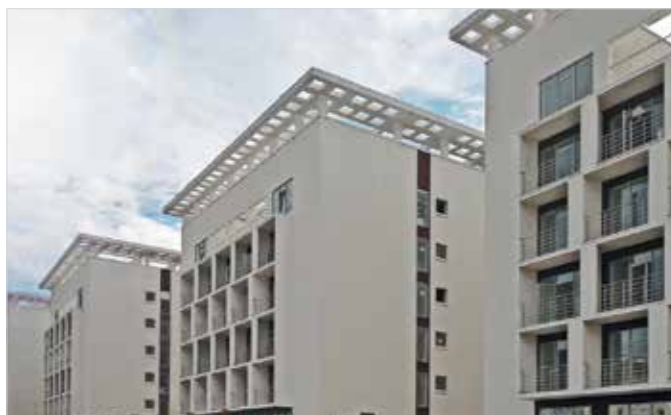
Гостиничный комплекс, Олимпийская деревня, г. Сочи. Мультизональные системы Electrolux.
