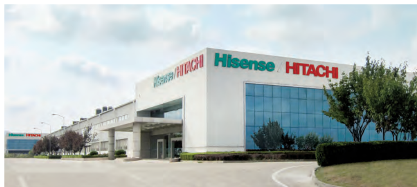
Завод Qingdao Hisense Hitachi Air-Conditioning system Co., Ltd., г. Циндао
