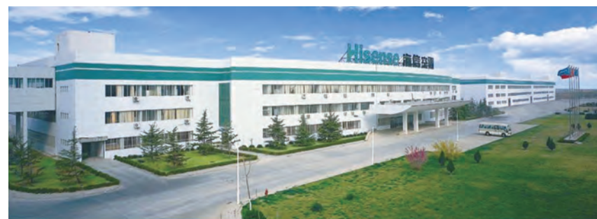
Завод Qingdao Hisense Hitachi Air-Conditioning system Co., Ltd., г. Циндао
